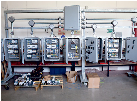
Электромонтаж между отдельными устройствами
